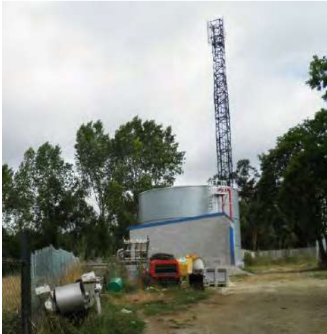
Depósitos de agua protección contra incendios y antena
