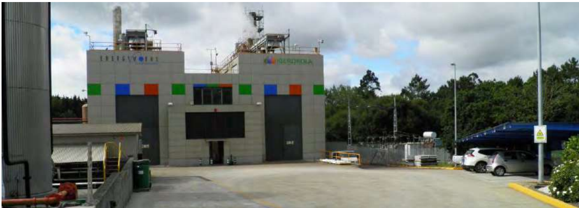
Industria de cogeneración Energy Works.
