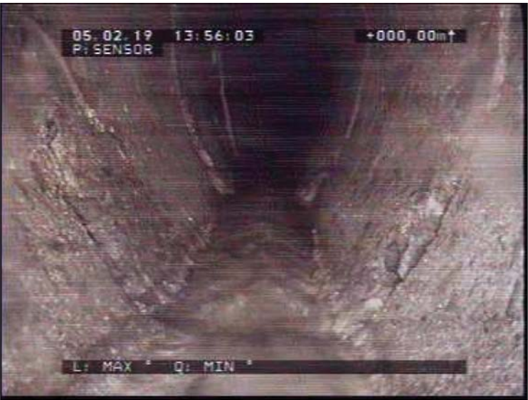
Figura 105. Ejemplo de filmación de red de saneamiento en ovoide. Fuente: Galaicontrol
